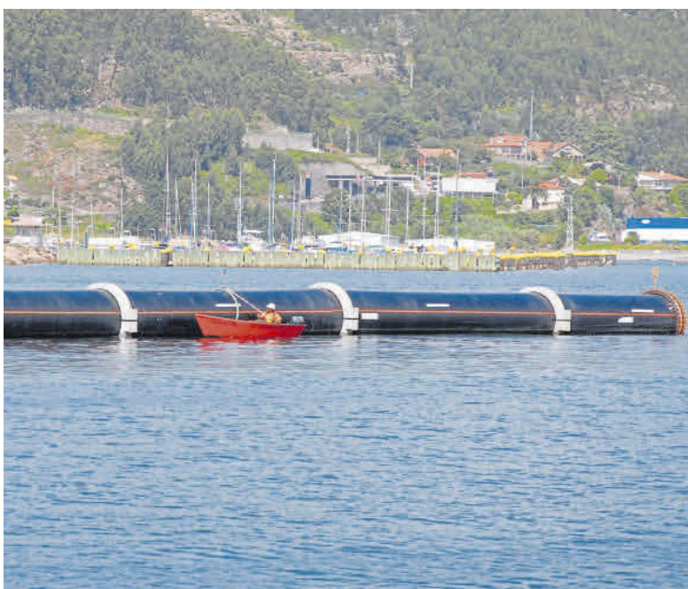
Trabajos de reparación de las bridas del emisario acometidos en la década pasada.
